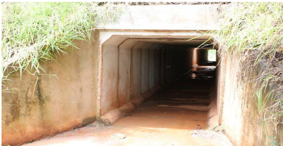
Figura 4- Duto de drenagem atravessando a rodovia SP-322 no Km
