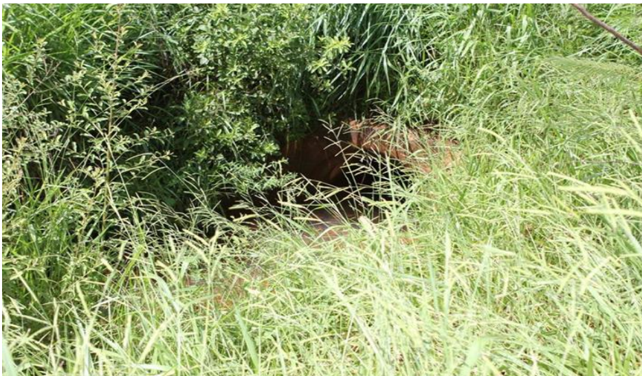
Figura 3- Duto de drenagem atravessando a rodovia SP-322 no Km 348,5 entre os municípios de Bebedouro e Sertãozinho, no Estado de São Paulo. Foto de Leonardo Beltrão Barszcz.
