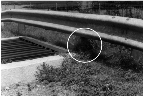
Figura 3.- Detalhe do ponto onde o mata-burro e as cercas encontram-se no Sistema de Proteção à Fauna da ESEC Taim – RS.
